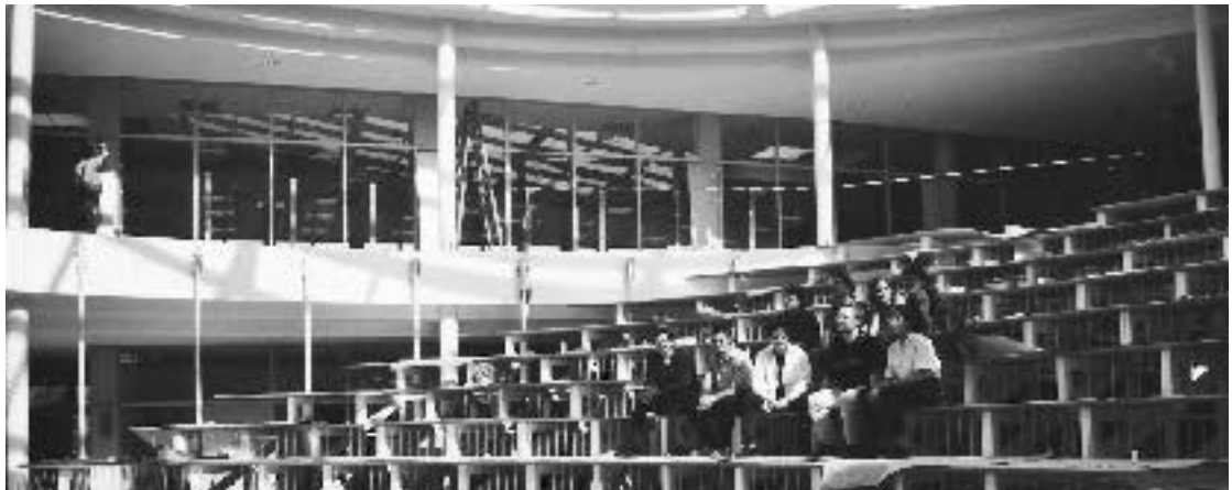
Neue TANNER-Mitarbeiter besichtigen während ihrer Schulung das Atrium der neuen Denkfabrik.
